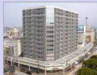
民間マンション (H19竣工) 名称: シティハウス富山西町 用途: 共同住宅 戸数: 101戸
