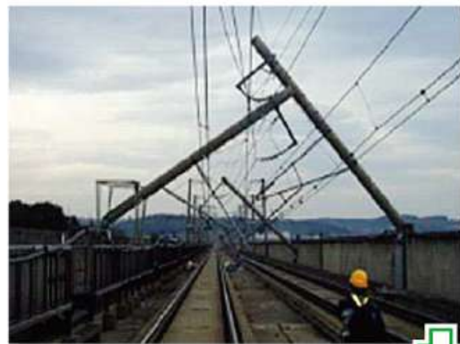
東北新幹線 仙台駅及び 高架橋電柱破損
